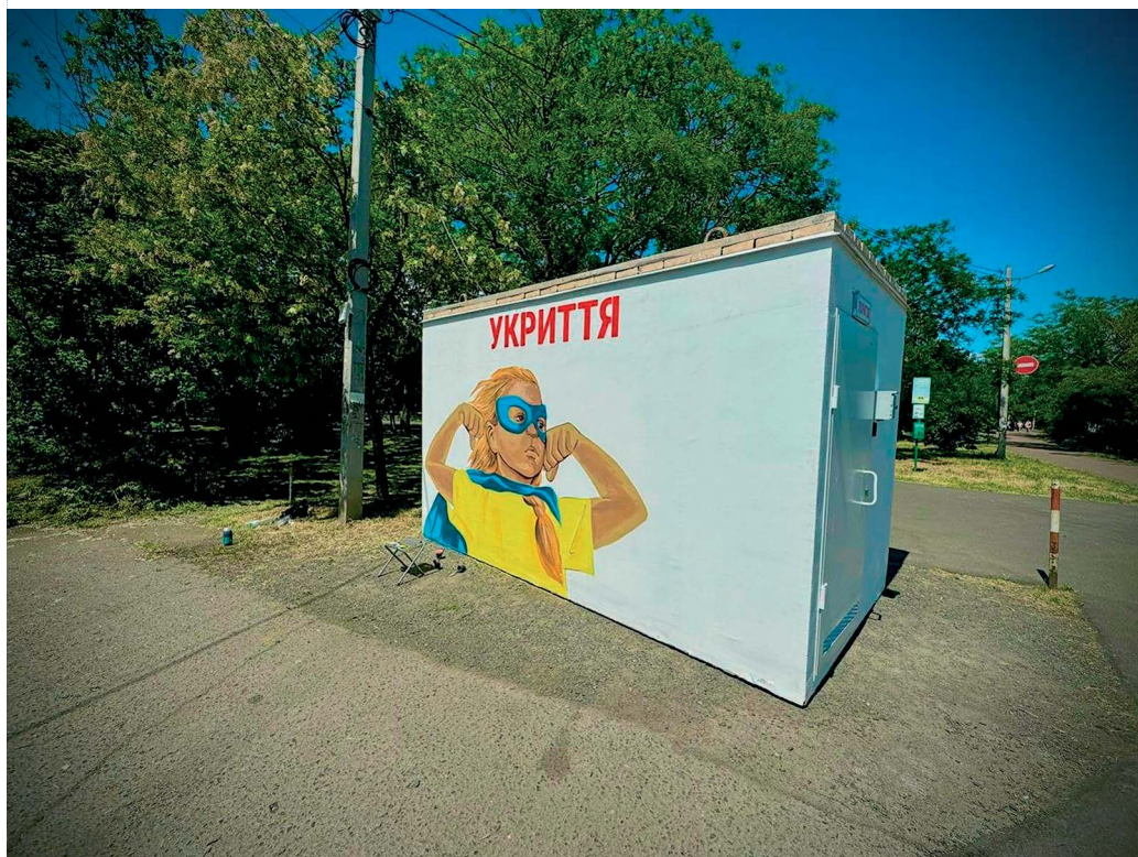
Фото 7. Мобільне укриття на схилах парку «Юність» в м. Одесі.
